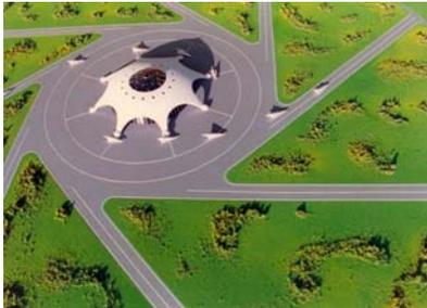
El domo central de este aeropuerto contiene terminales, instalaciones de mantenimiento, servicios y hoteles. Las pistas están dispuestas en una configuración radial que permite a las aeronaves despegar fácilmente a favor del viento y evitar peligrosos aterrizajes con viento en contra. Estaciones de emergencia a los
